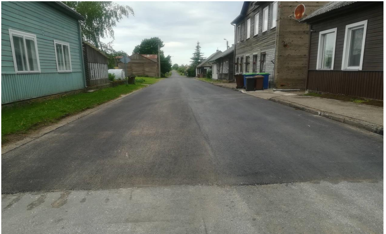
4 pav. Atliktas gatvės viršutinio dangos sluoksnio atstatymas Kaštonų gatvėje, Gruzdžiuose.
